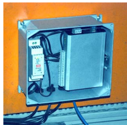
Obr. 3. Zařízení zpracovávající naměřené analogové hodnoty z proudových snímačů, které v digitální podobě předává do podnikové sítě – datalogger
